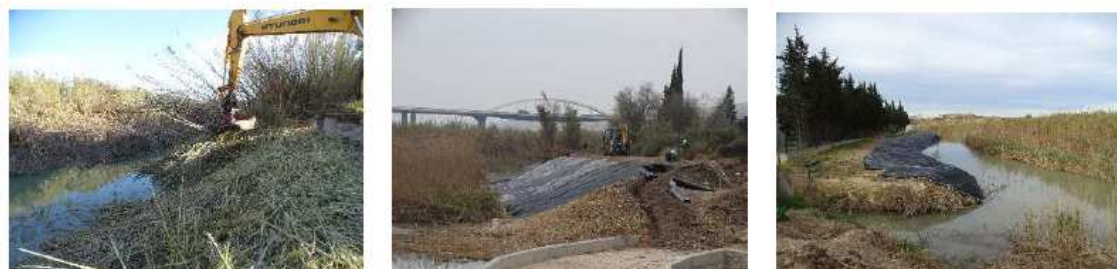
Trabajos para la recuperación del bosque de Ribera
